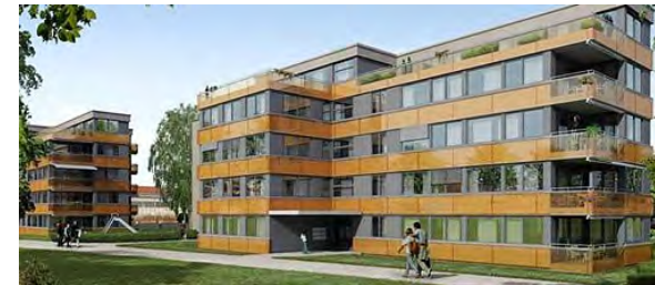
Siedlung nach Anforderungen Energiegesetz 2009 Kt. ZH
