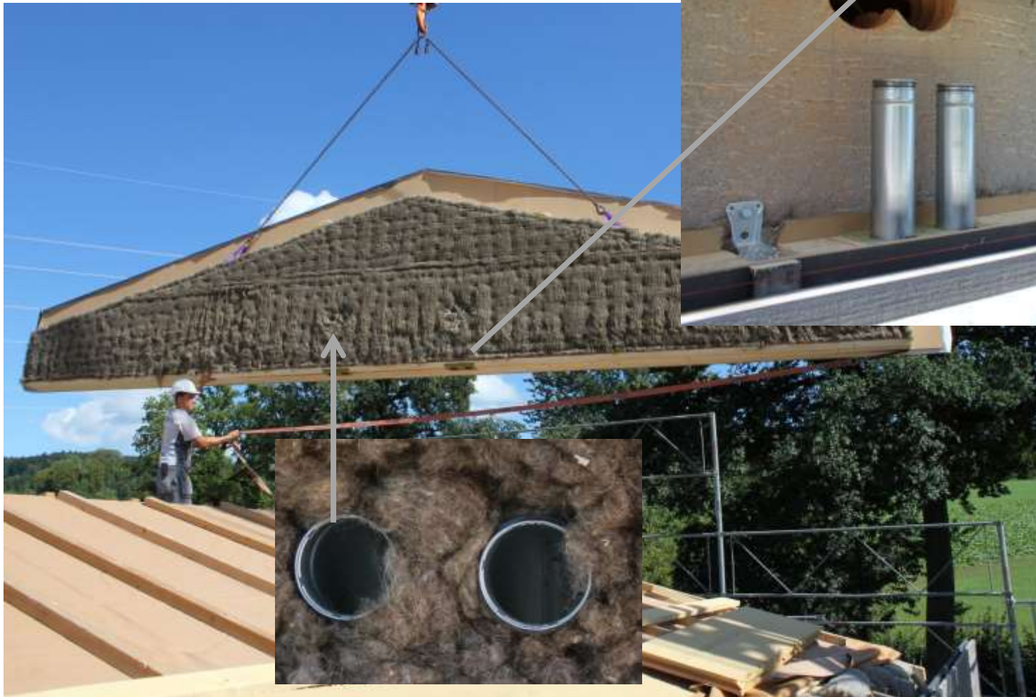
Bilder: Pilotprojekt Krumbach (CEM, FHNW, IEBau, Muttenz)
